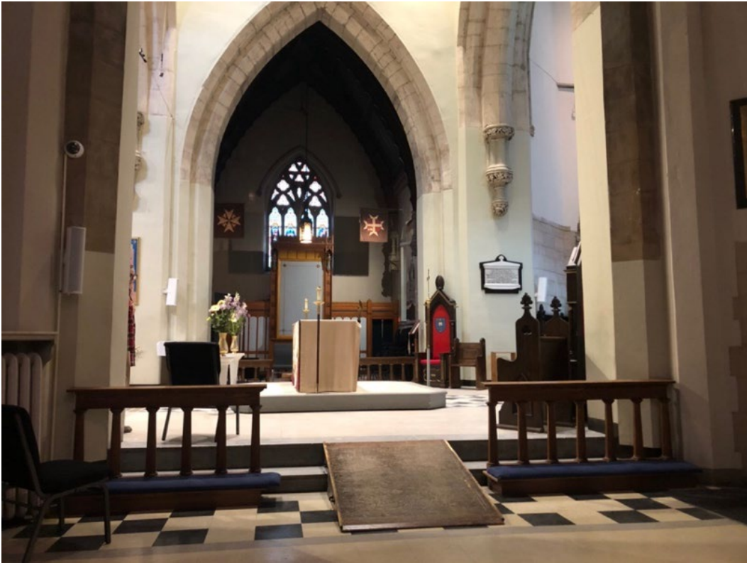
Illustration 22 - Rampe en bois amovible sur le côté droit du transept
