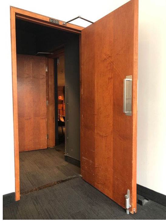
Illustration 13 - Porte ouverte, avec vue sur l'accès salle
